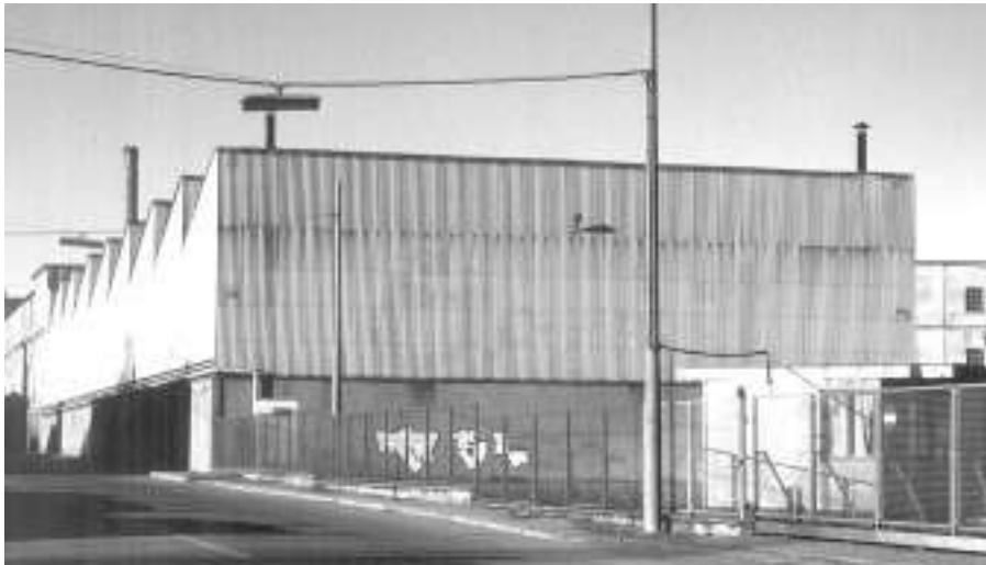
Intanto Rifondazione Comunista mette in evidenza che «in Italia sono sparsi, dai 5 ai 10 milioni di tonnellate d'amianto» e che «recentemente un gruppo di epidemiologici ha pubblicato in Inghilterra un dato tanto significativo quanto preoccupante: sono previsti per
