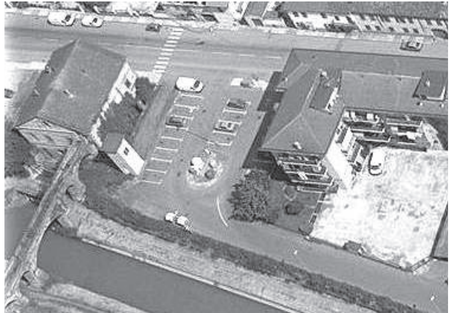
A sinistra la centrale di sollevamento, oggetto dell'intervento
